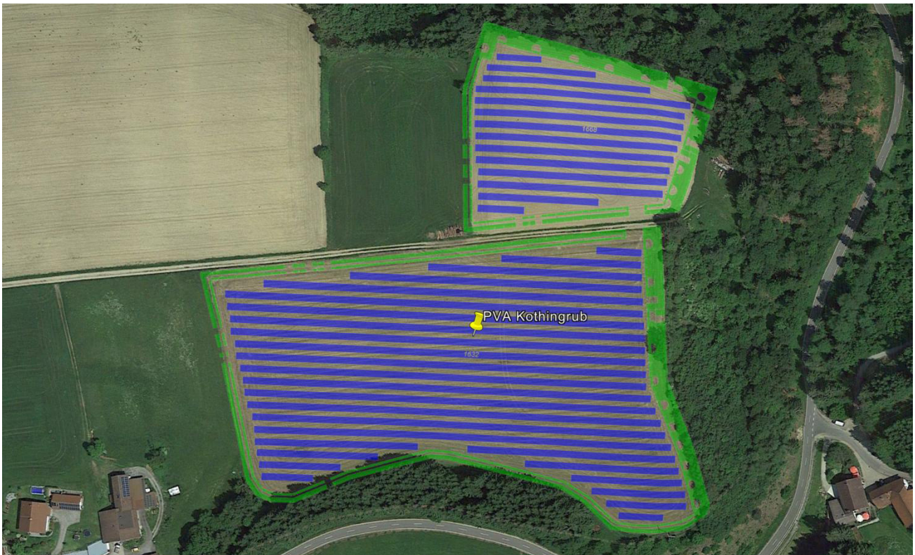
Bild 2.3: Luftbild der PV Anlage (Quelle: Google Earth / SolPEG)
